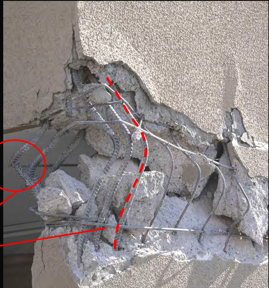
Edificio – Terremoto Chile 2010
